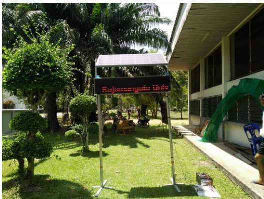
ภาพที่ 14 การติดตั้งและทดสอบระบบ
