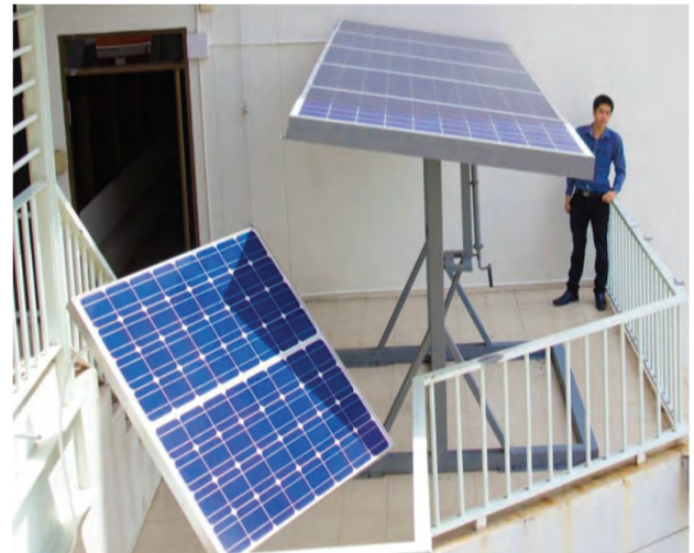
ภาพที่ 8 แผงเซลล์แสงอาทิตย์ ขนาด 1.2 kW 150 V
