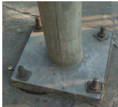
ภาพที่ 2 การยึดสลักเกลียวของเสาไฟฟ้าส่องสว่าง
