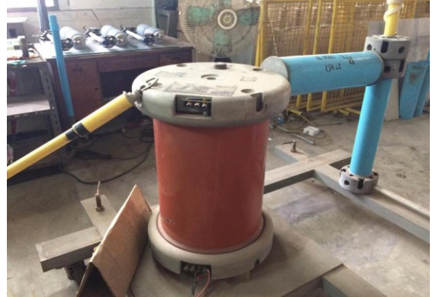
ภาพที่ 4 : หม้อแปลงไฟฟ้า
