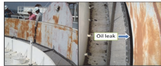
ภาพที่ 5 Seal Roof Leak T-301B
